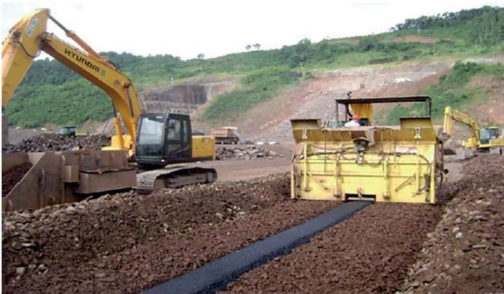
Figura 58. Colocación del material de transición para la primera capa de concreto asfáltico.
