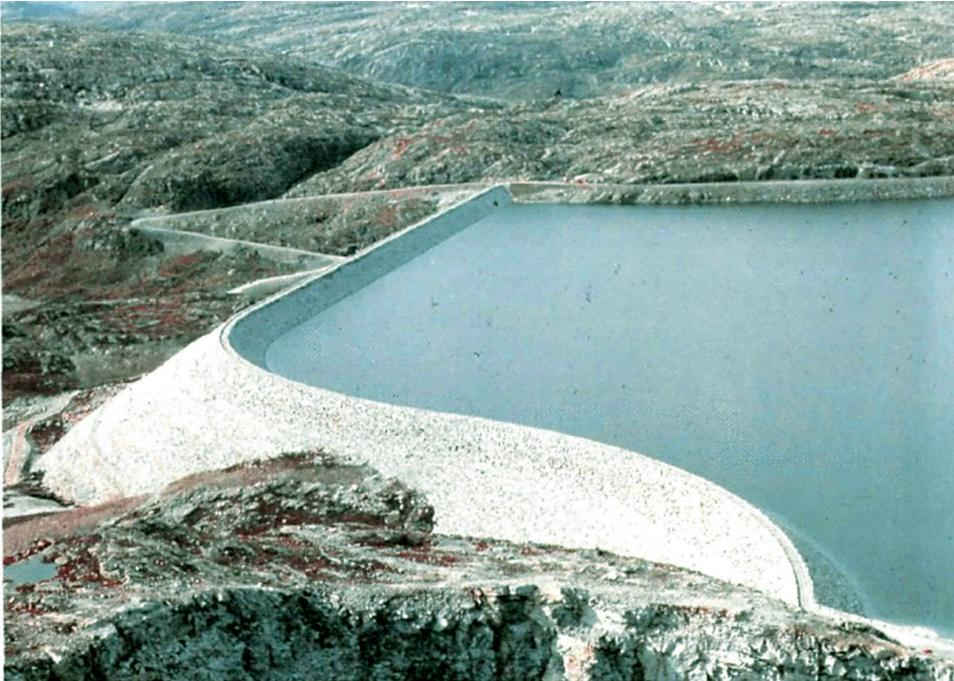
Figura 78. Alineamiento inusual del eje de presa ACCRD Storvan-1987 en Noruega a 60 Km de Stavanger.
