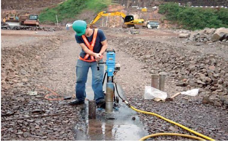
*Figura 66. Extracción de muestras de concreto asfáltico con diamantina.*
