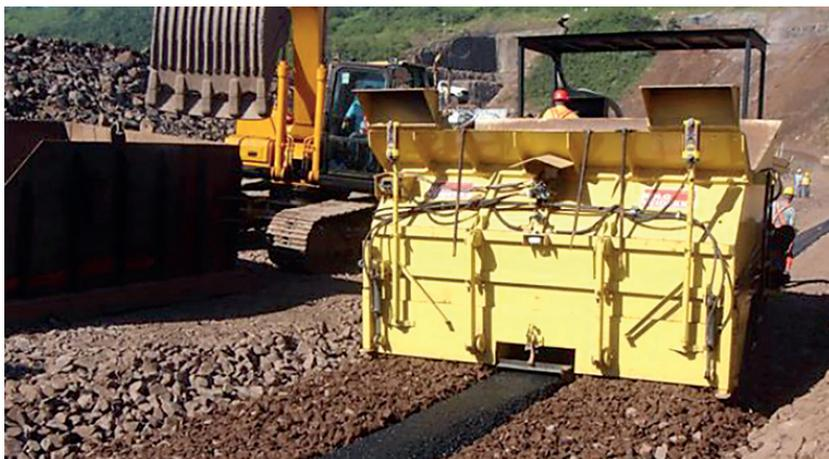
*Figura 42. Colocación de mezcla asfáltica y transición fina (Hoeg, 2009).*
