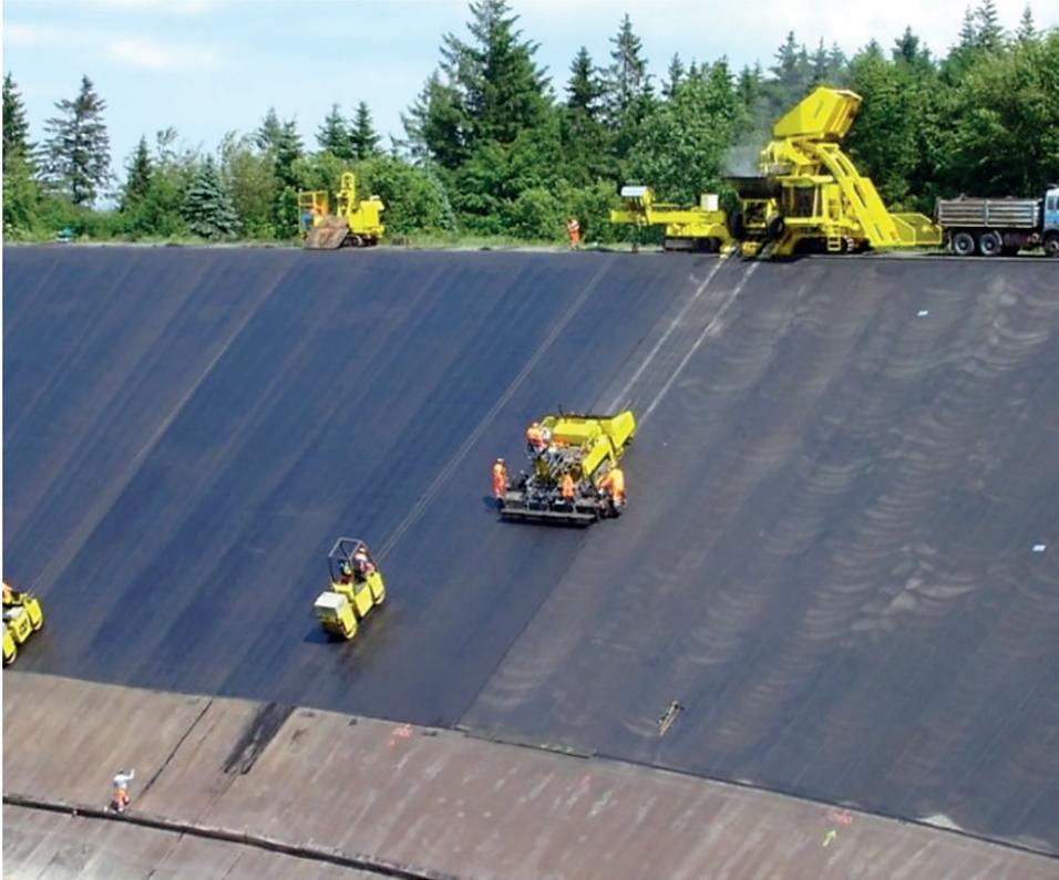
*Figura 28. Colocación de face impermeable asfáltica para longitud de talud extensos.*
