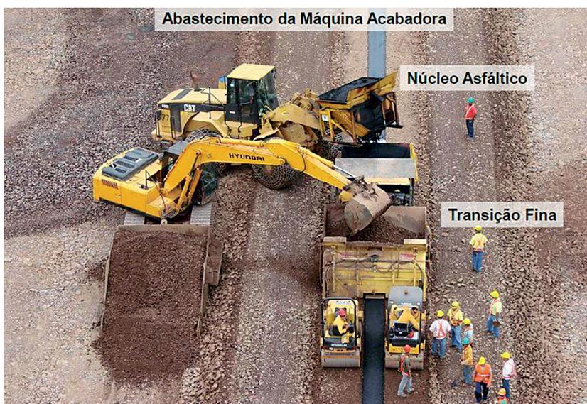
*Figura 60. Aplicación y suministro de materiales, mezcla asfáltica y transiciones (Camargo Corrêa, 2010).*
