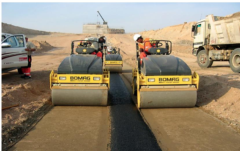
*Figura 43. Proceso de compactación con rodillos de confinamiento del núcleo de asfalto (Hoeg, 2009)*
