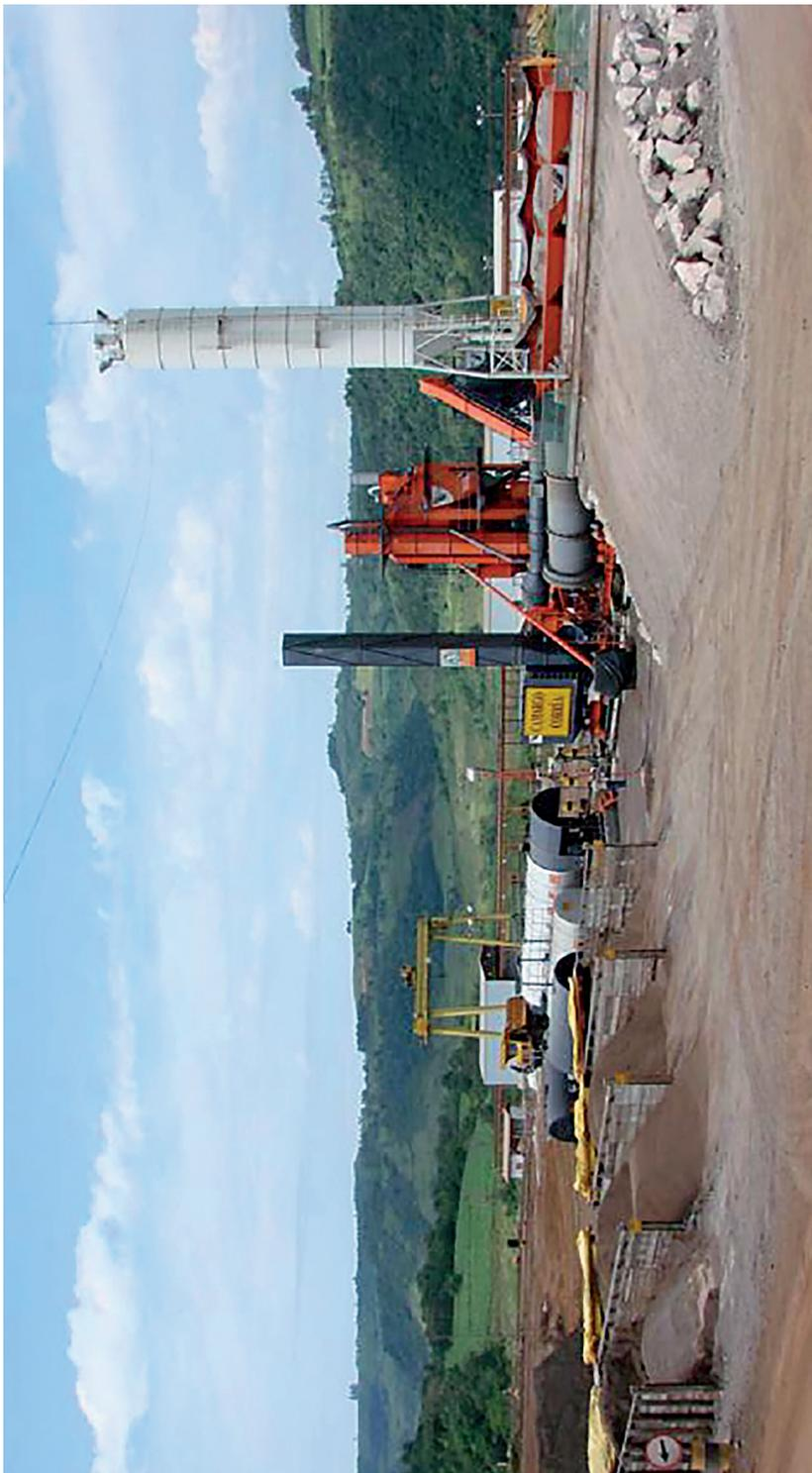
Figura 69. Planta de Concreto asfáltico ubicado en la construcción de la Presa Foz de Chapecó.
