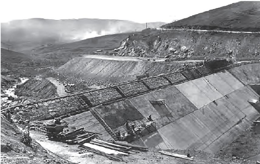
*Figura 8. Primeras construcciones de Presas con cuerpo de enrocado lanzado (Brazil, 1933).*
