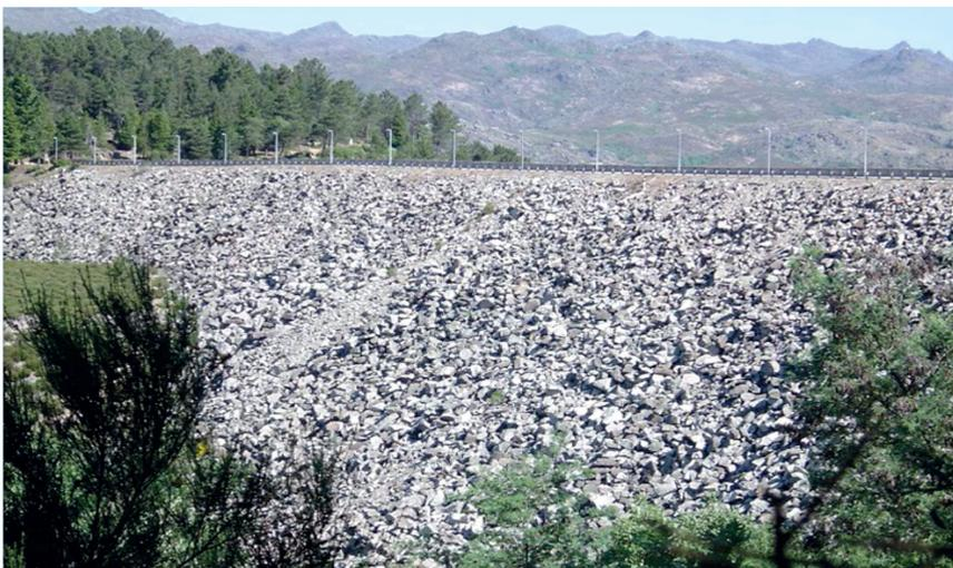
*Figura 9. Talud con material de enrocado lanzado Presa Paradela (Portugal, 1955).*
