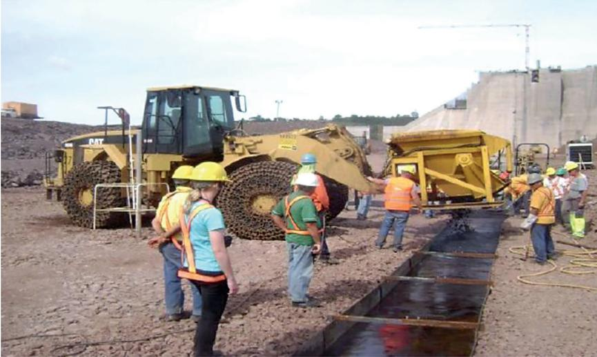
Figura 48. Construcción de las capas iniciales del núcleo (Hydro-Québec, 2008).
