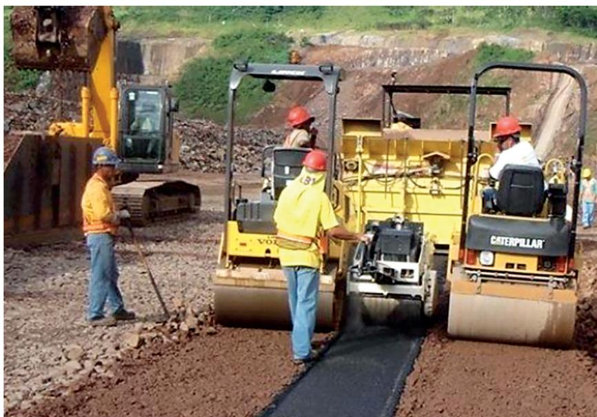
*Figura 62. Colocación y compactación del concreto asfáltico en vías experimentales (Guimaraes, 2011)*
