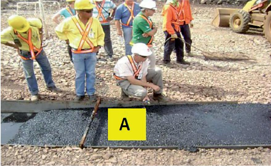
*Figura 64. Medición de la temperatura del concreto asfáltico antes de la compactación (A).*
