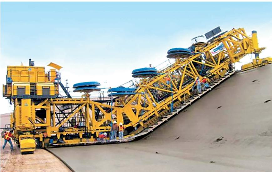
*Figura 27. Colocación y compactación del talud aguas arriba con base asfáltica (Walo, 1997)*
