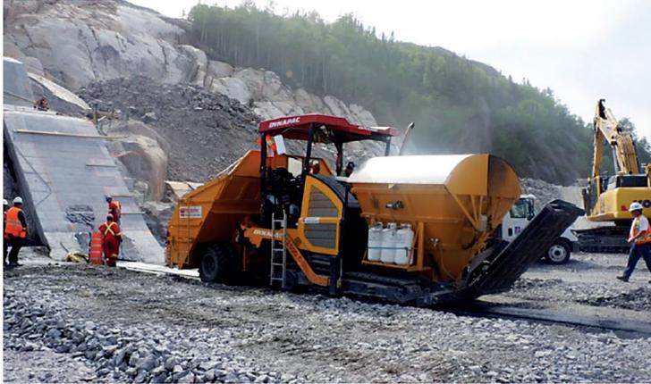
Figura 56. Colocación inicial de las capas de mezcla al cerrar las estructuras (Camargo Corrêa, 2010).
