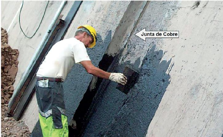
Figura 57. Aplicación de mezcla asfáltica en juntas (Camargo Corrêa, 2010).
