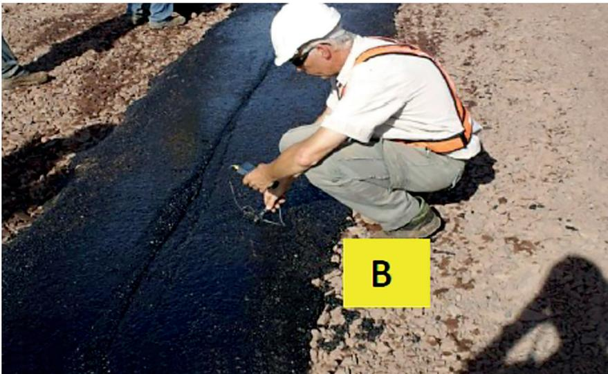
*Figura 65. Medición de la temperatura del concreto asfáltico después de la compactación (B).*
