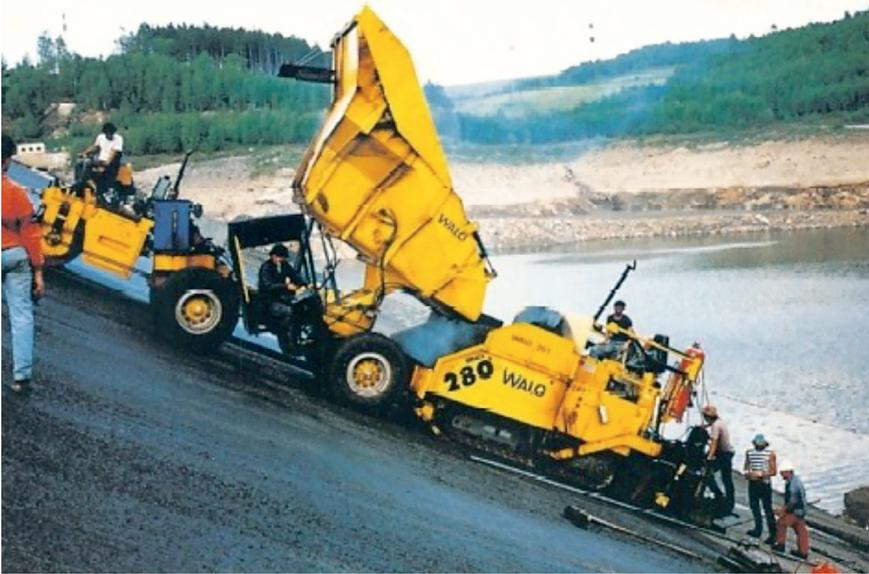
*Figura 26. Colocación del ligante asfáltico en el talud (Walo, 1994).*
