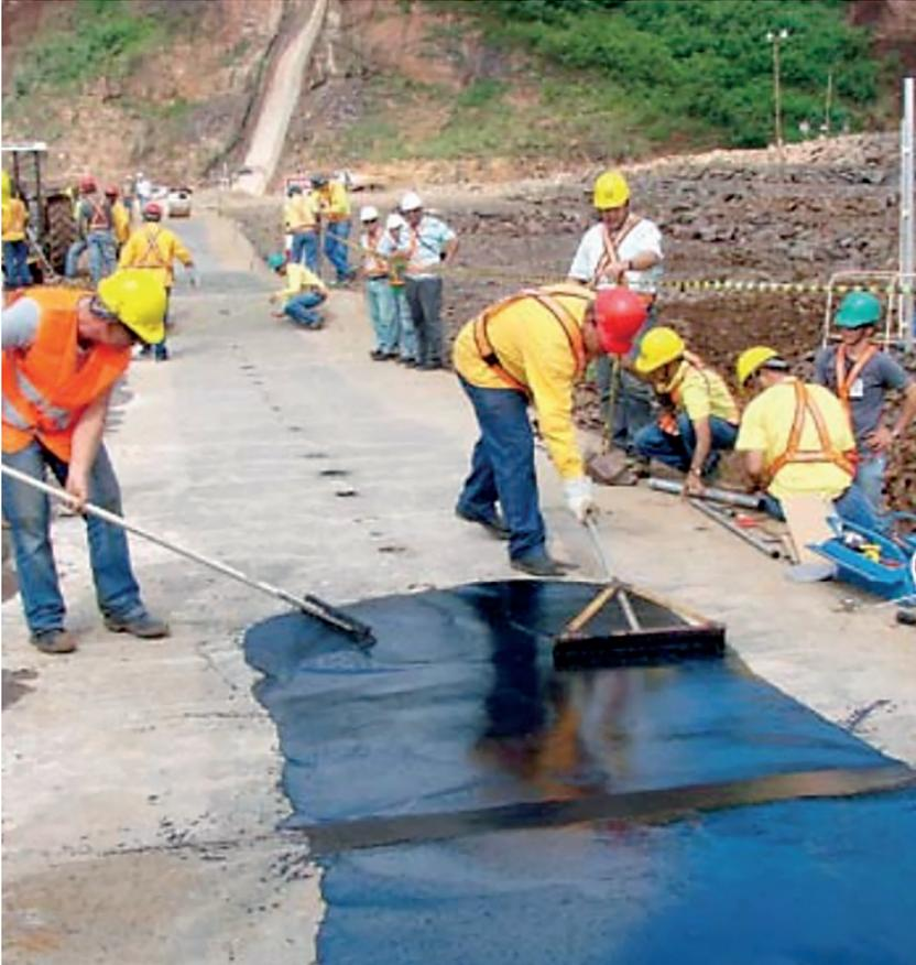
*Figura 54. Aplicación del imprimado (mastique) bituminoso (Guimaraes, 2011).*
